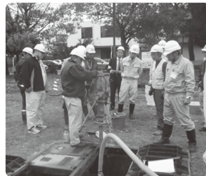
手押しポンプ設置作業の様子
